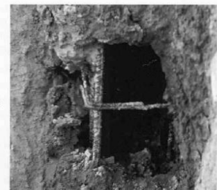
Fig. 4.44 Estacas Strauss com concreto de baixa trabalhabilidade, provocando descontinuidade de seção na retirada do revestimento
