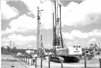
Obra na usina de pelotização - CVRD
