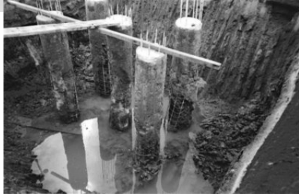
Estacas em executadas em antigos aterros sanitários
